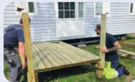
Trois nouveaux mobil-home ont été installés dans le camping municipal au printemps 2025.
