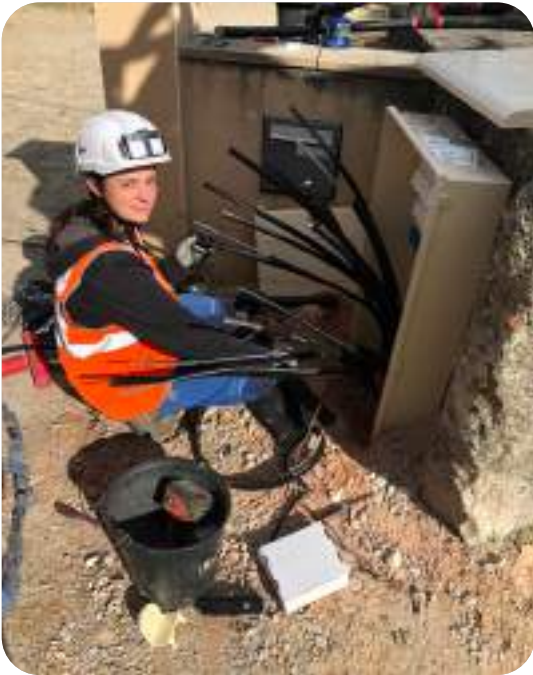
Travaux d'effacement des lignes électriques.
