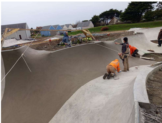
Concrete flow a finalisé toutes les surfaces à la main
