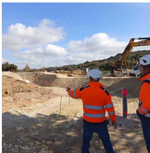
Les travaux de terrassement en passe d'être terminés
