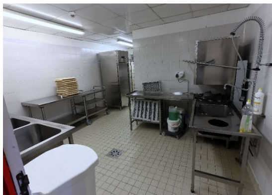
Bâtiment A zone process repas
