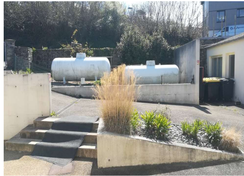
Cuves à gaz
