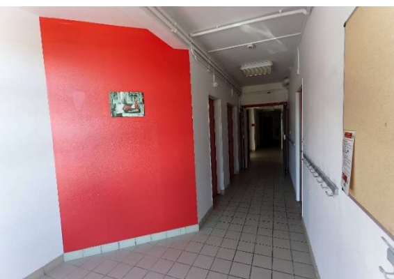
Bâtiment B espaces de circulation
