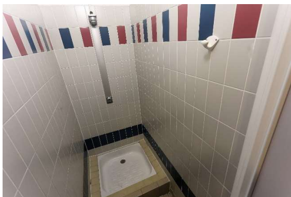
Bâtiment B sanitaire
