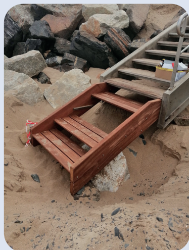
L'escalier de l'école de surf a été rallongé afin de s'adapter aux variations de niveau du sable de la plage.
